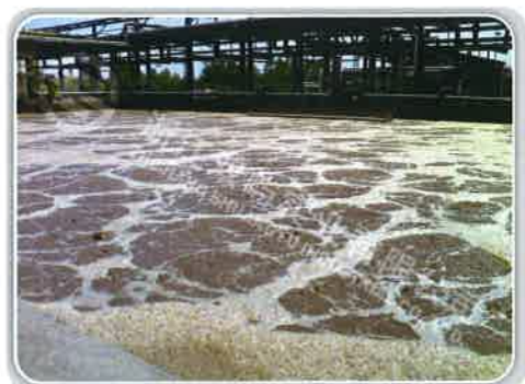
石家庄化纤应用现场
